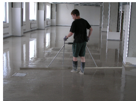
Nivelace a odvzdušňování tekutého potěru pomocí „rádla“.
