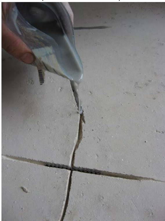
Sanace trhlin sponkováním MFC Ekopox 670:
