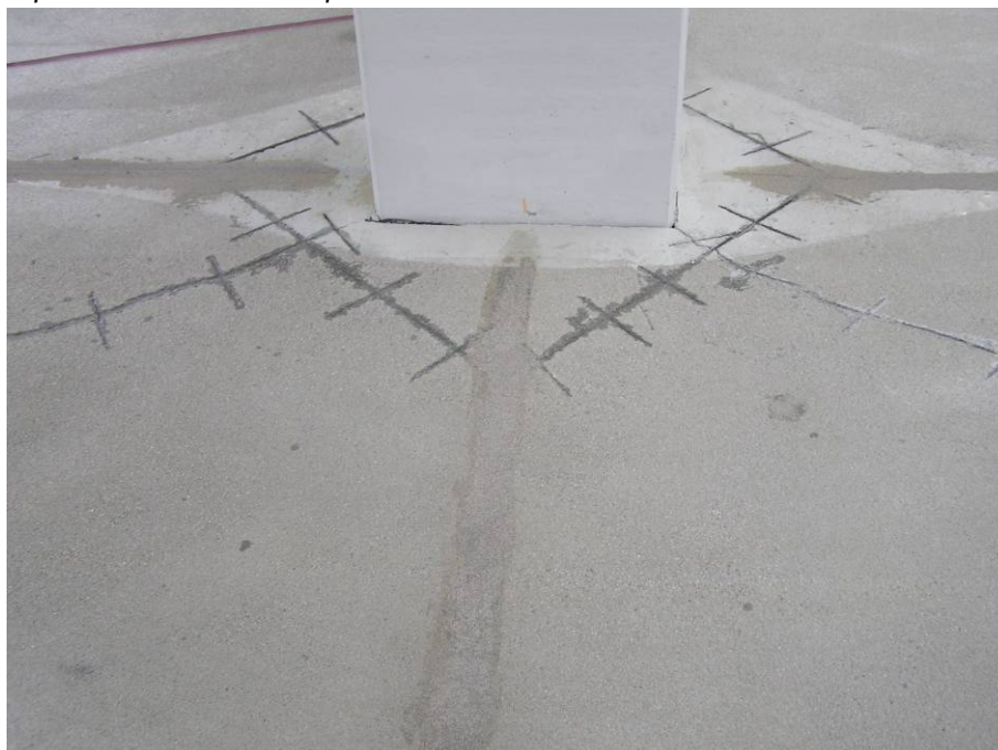
Sanace trhlin sponkováním MFC Ekopox 670:
