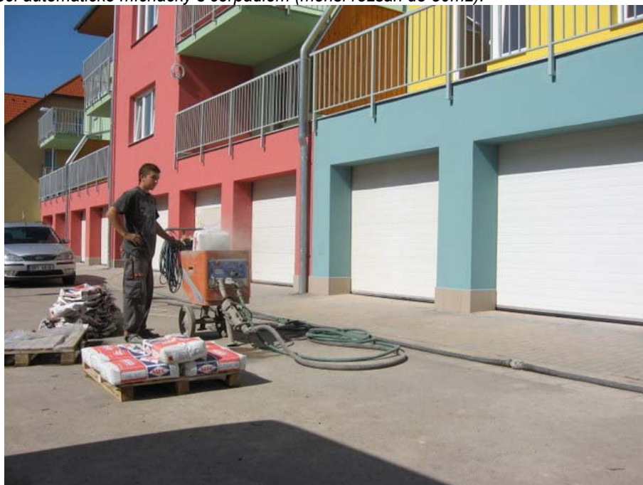
Míchání pomocí automatické míchačky s čerpadlem (menší rozsah do 50m2):
