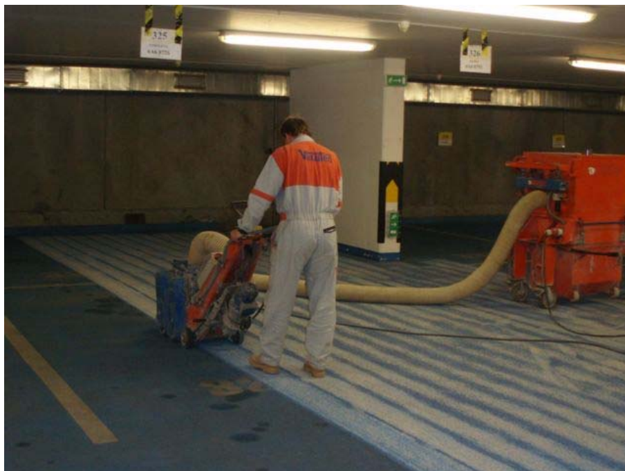
Frézování podkladu:
