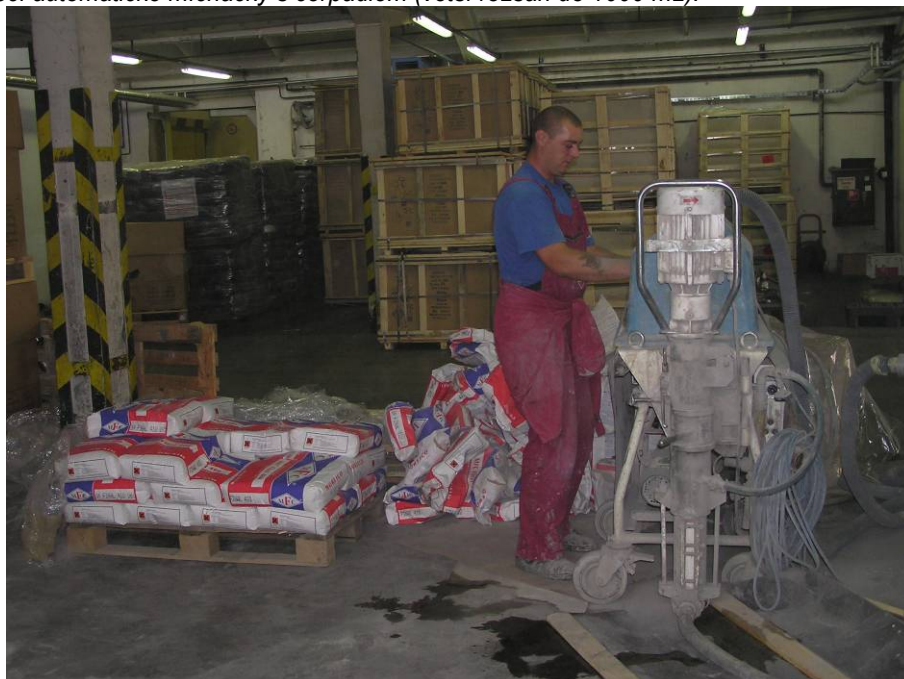
Míchání pomocí automatické míchačky s čerpadlem (větší rozsah do 1000 m2):
