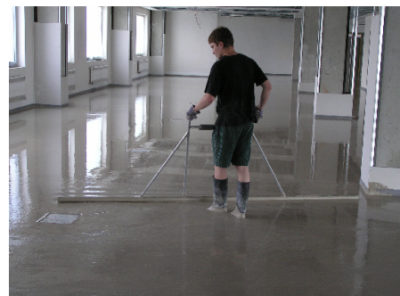
Nivelace a odvzdušňování tekutého potěru pomocí „rádla“.
