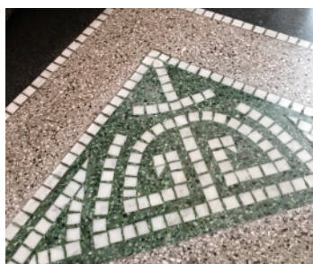
Povrchová úprava podlahy MFC Micro Terrazzo CP
