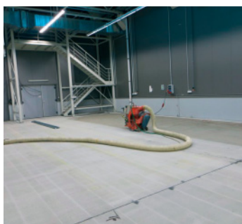
Povrchová úprava průmyslové podlahy
