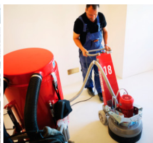
Povrchová úprava podlahy MFC Micro Terrazzo CP
