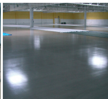
Vyrovnání průmyslové podlahy pod syntetickou stěrku
