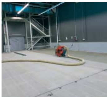
Обработка поверхности промышленных полов
