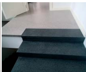
Обработка поверхности пола MFC Micro Terrazzo CP
