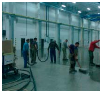
Обработка поверхности с выравнивающим слоем при реконструкции промышленных полов
