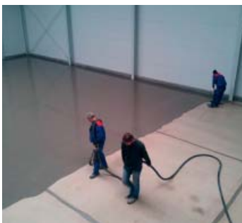
Обработка поверхности с выравнивающим слоем при реконструкции промышленных полов
