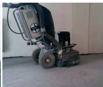
Обработка поверхности пола MFC Micro Terrazzo CP
